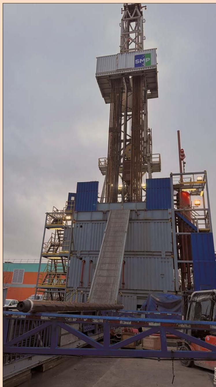
À Alfortville, le forage de nouveaux puits va permettre de remplacer les installations actuelles créées il y a une quarantaine d'années et qui ont souffert de la corrosion.
